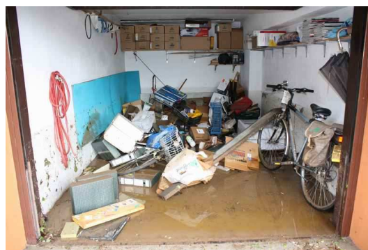
Maggio 2010 – Garage dopo l'allagamento
