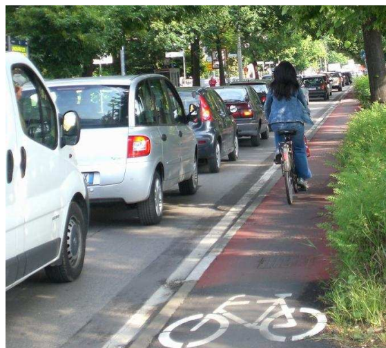
il tratto di pista ciclabile rialzata permette ai ciclisti di passare velocemente e in sicurezza fianco della colonna di auto
