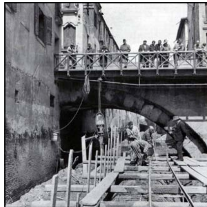
Die Brücke während der Versiegelung des Kanals.
