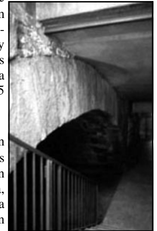
Visita actual a la arcada del puente
