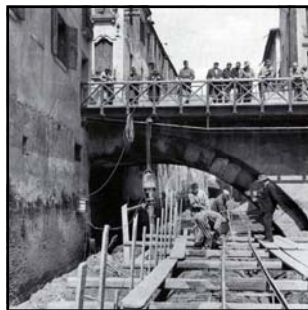
El puente durante el soterramiento
