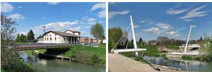
Il canale Brentella all'altezza della costruenda passerella pedonale della Pelosa.
